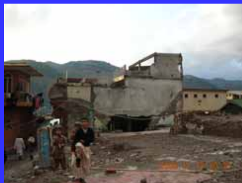
崩壊した家屋
