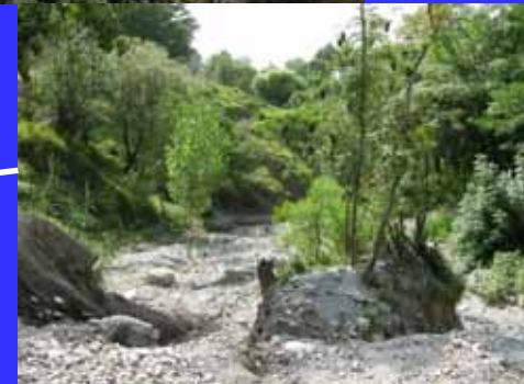
市街地東部の土石流
