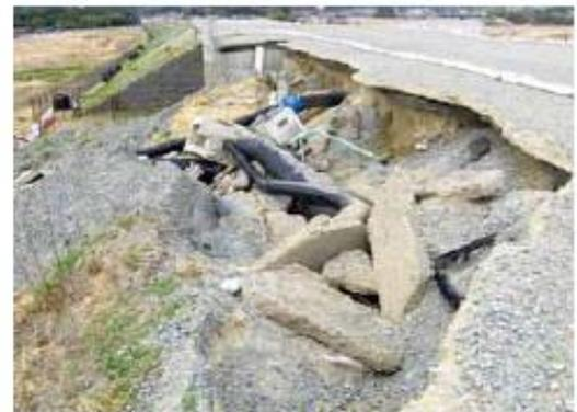
写真 1 アクセス道路の被災状況
